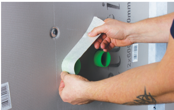
Bruk maskeringstape for å unngå søl på røret.
