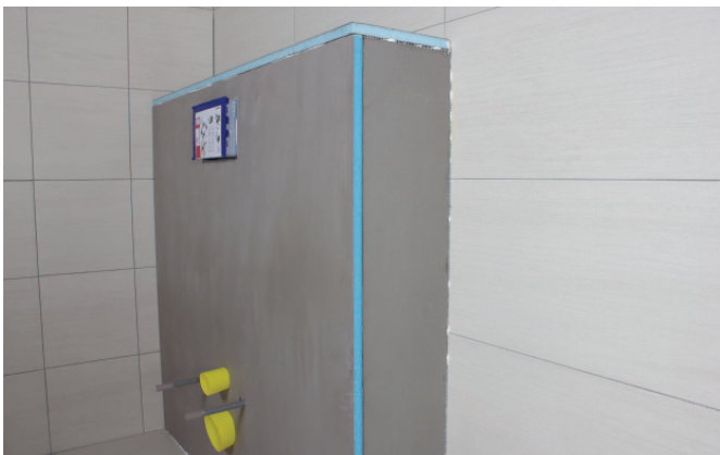
Lag drepsåpning og forsterkning.
