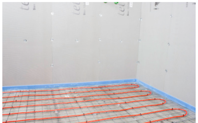
Benytt armeringsnett når dette er påkrevd.
