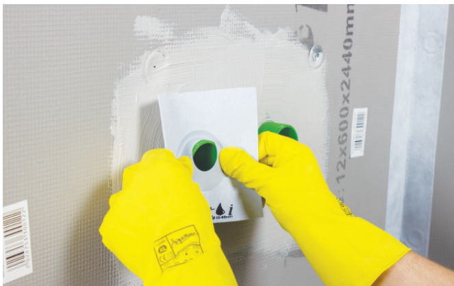
Tre mansjettten forsiktig på røret.
