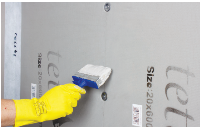
Påfør membran på hver side av plateskjøt.
