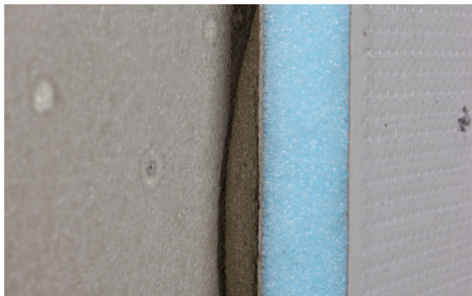
Fest platen på vegg og kontroller innretning.
