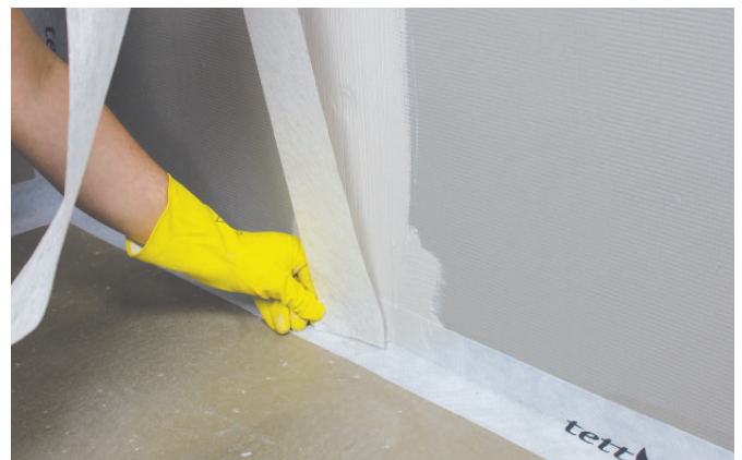
Legg fiberremsen i våt membran.
