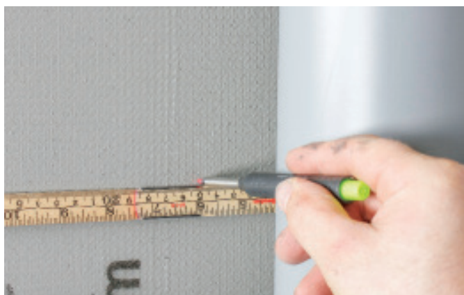
Ta mål og tilpass rørkassen i høyde.
