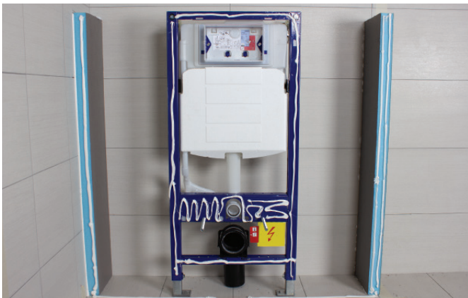
Ta mål og tilpass kassen
