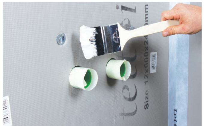
Påfør membran i et tilstrekkelig stort område.
