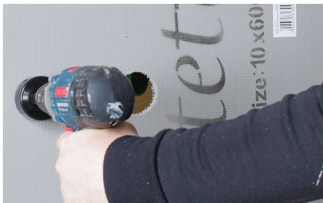
Det er enkelt å ta hull med hullbor.
