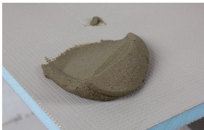
Legg på tilstrekkelig med lim.
