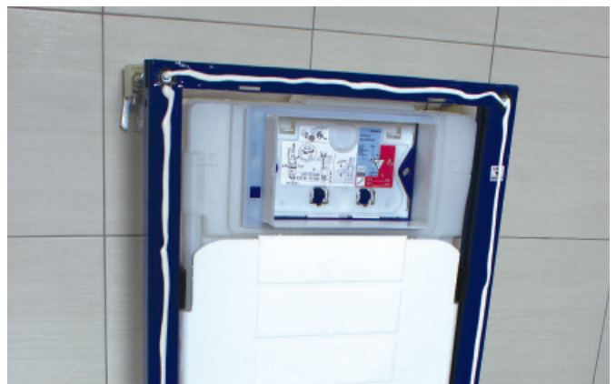
Påfør monteringslim på ramme, vegg og gulv.
