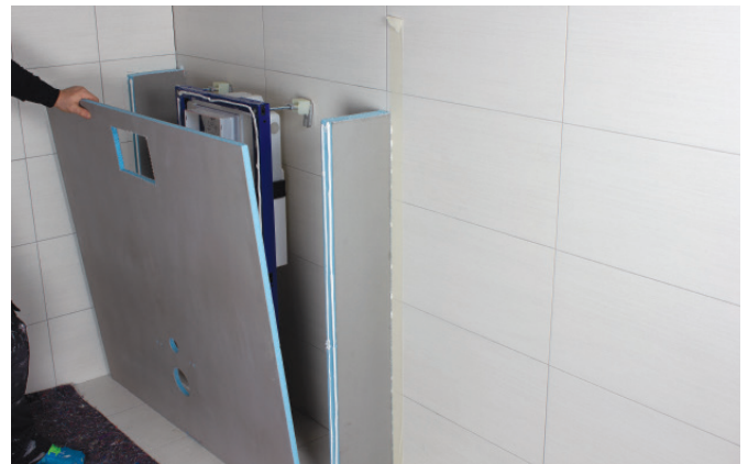
Påfør monteringslim på ramme, vegg og gulv.
