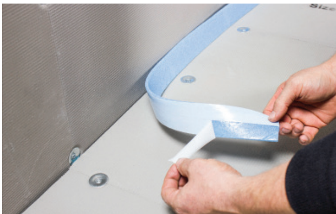
Benytt ekspansjonsbånd langs alle vegger.
