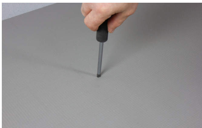
Lag hull til senter av limpunktene.
