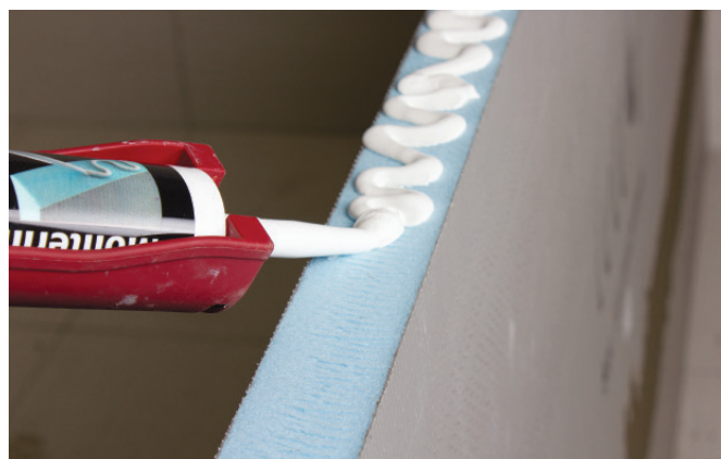
Påfør tilstrekkelig med Tetti monteringslim.
