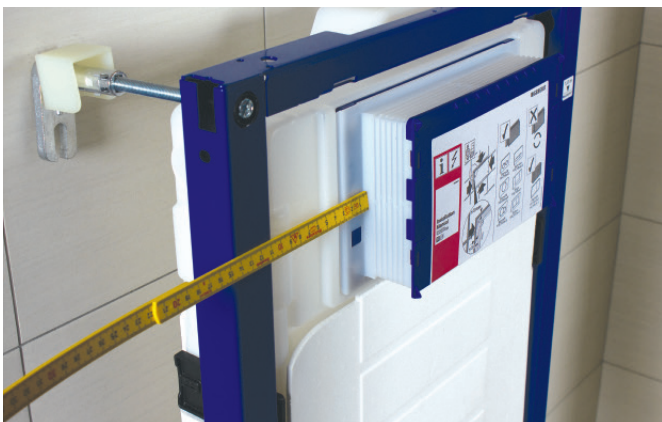
Ta mål og tilpass kassen
