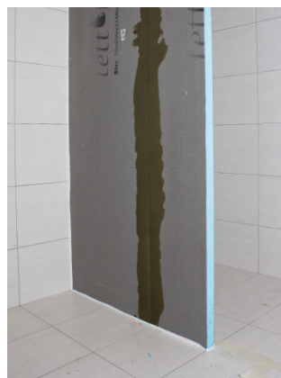
Dusjvegg klar for flislegging.
