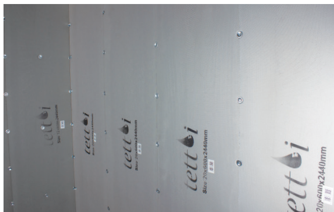
Fest skrue med monteringskive i alle skjøter, maks avstand 30 cm.
