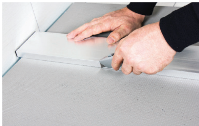
Platene kuttet enkelt med tapetkniv.
